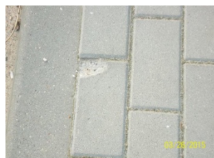
zanizienie względem krawężnika, obrzeża poniżej 0,0 cm
