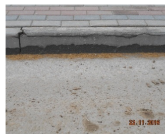
rozwarstwienie krawężnika
