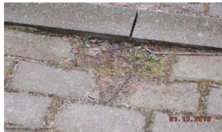
zanizienie względem krawężnika, obrzeża poniżej 0,0 cm
