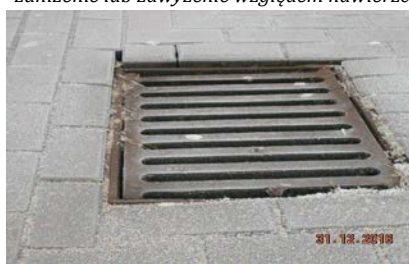
Kratki ściekowe, pokrywy włazów zanizienie lub zawyżenie względem nawierzchni o 0,5 cm do regulacji
