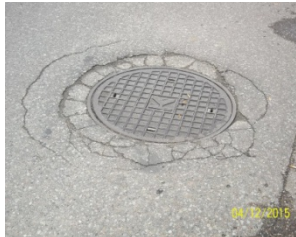
źle wykonana "łata" - niedowałowane, masa gruboziarnista
