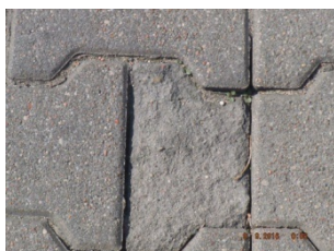
zanizienie względem krawężnika, obrzeża poniżej 0,0 cm
